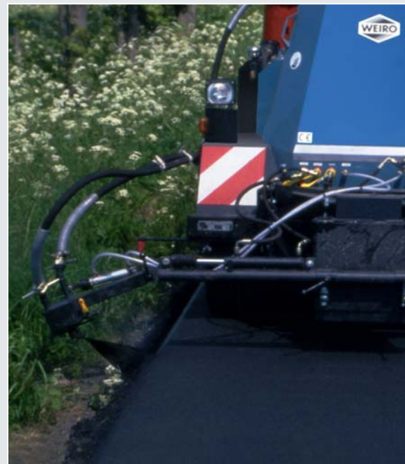
Die Ausbringung des Bindemittels erfolgt in genauer Dosierung durch die kontrollierte Fahrgeschwindigkeit und den vorgewählten Spritzdruck bei definierter Durchflussmenge.
