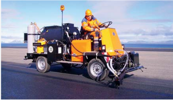
TM 504 SH bei der Beschichtung einer Arbeitsnaht
