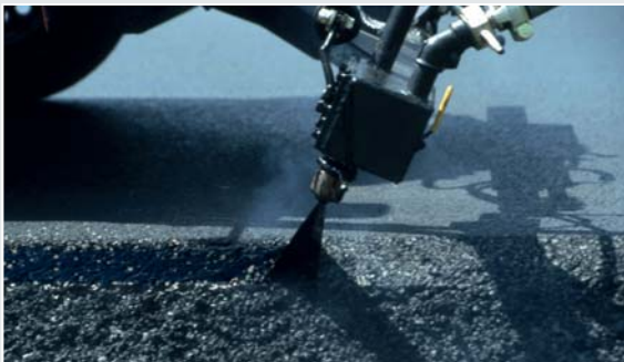
Beschichtung des hohen Randes mit Zirkulations-Düsenkopf
