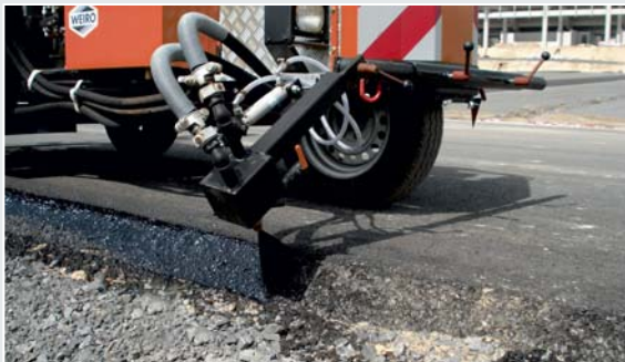
Beschichtung des hohen Randes: genaue Dosierung des Bindemittels durch kontrollierte Fahrgeschwindigkeit bei voreingestelltem Spritzdruck
