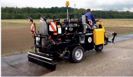
Flächenanspritzung zur Herstellung eines optimalen Schichtenverbundes: dosiergenau bei hoher Flächenleistung
