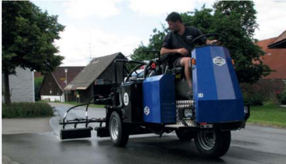
Qualitätsbestimmend: Die Ausbringung des Bindemittels erfolgt in genauer Dosierung durch die kontrollierte Fahrgeschwindigkeit und den vorgewählten Spritzdruck bei definierter Durchflussmenge.
